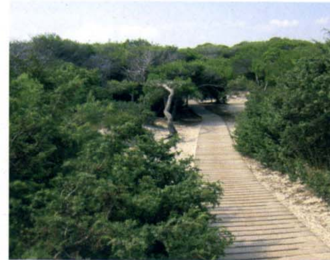
Passarel·la de fusta per evitar l'erosió de la duna
