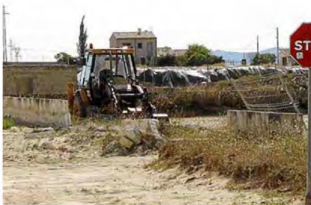
La maquinària pesant tornà dilluns als voltants de la zona.
