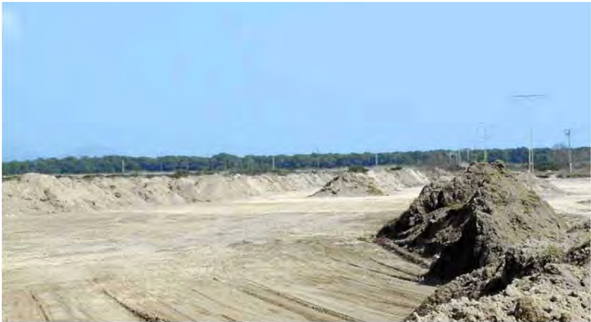
L'empresa que impulsa el projecte ha duit a terme darrerament moviments de terra a la zona on es projecta el camp de golf de Son Bosc.
