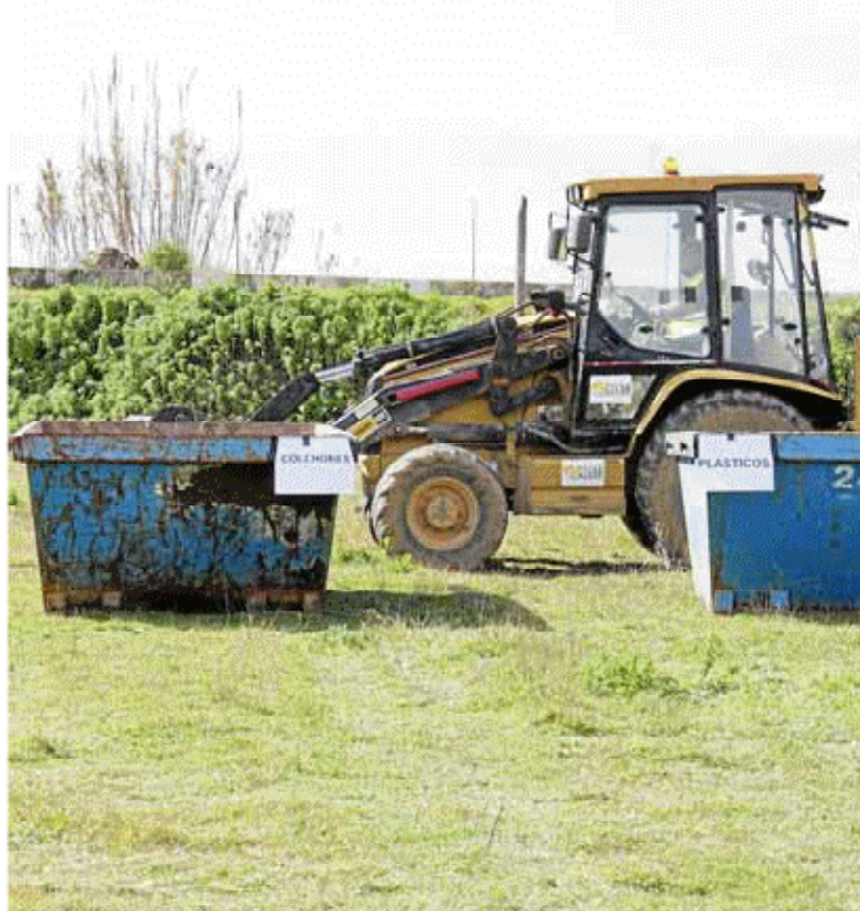
Les obres de construcció del camp de golf s'iniciaren ahir. Foto: M. Serra
