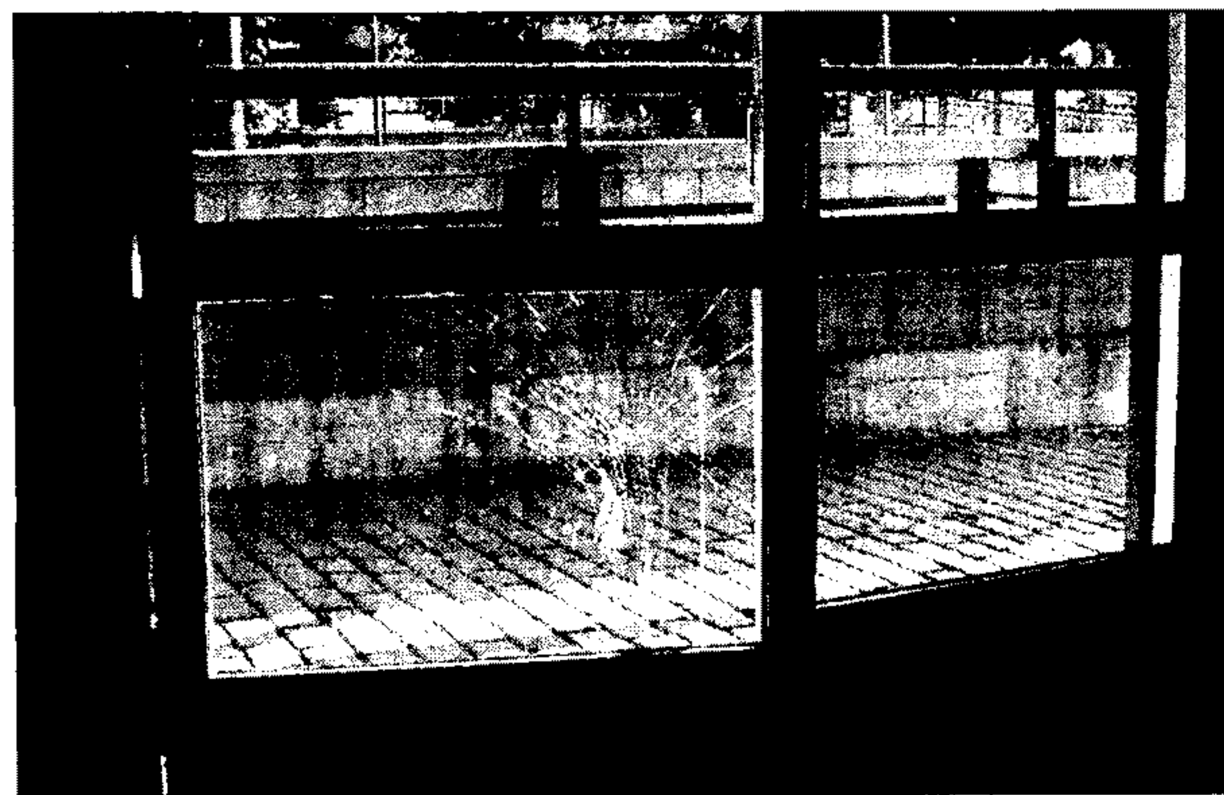
Uno de los cristales de la puerta principal está roto. Foto: J. F. S.
