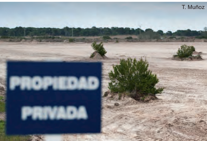
A la part de Son Bosc no protegida pel PORN ja han començat les obres
