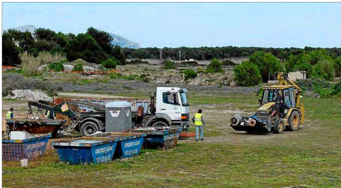
Las obras en los terrenos de Son Bosc, iniciadas en febrero y retomadas el pasado lunes tras un parón de cuatro meses. / CATI CLADERA
