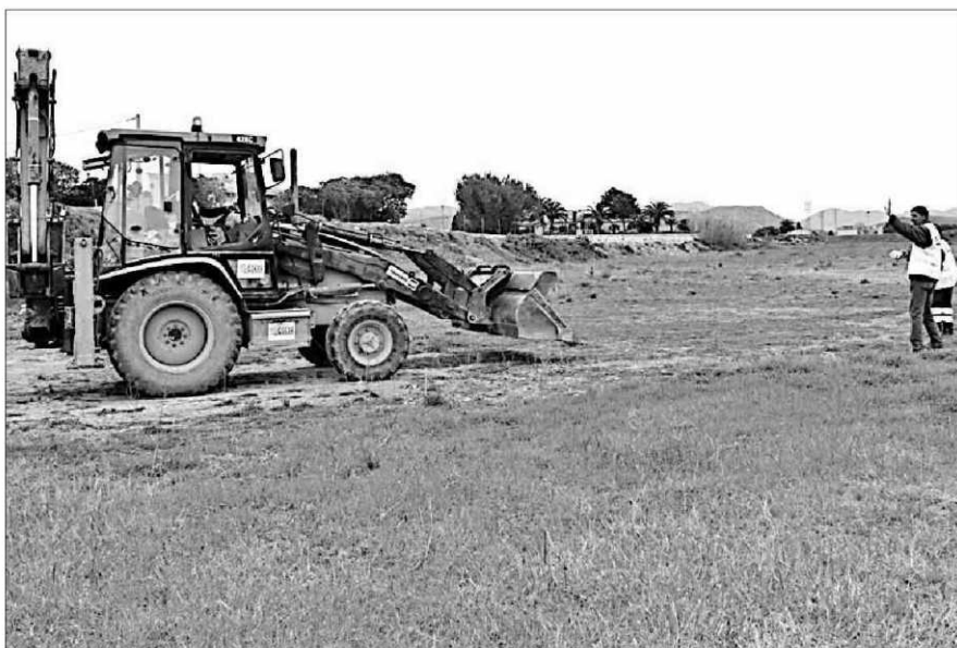
Terrenos de Son Bosc, donde ya habían empezado las obras.
